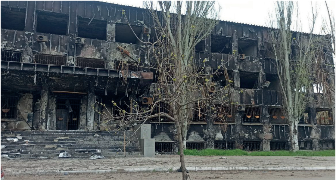
Зруйнована будівля Донецького апеляційного суду в Маріуполі
